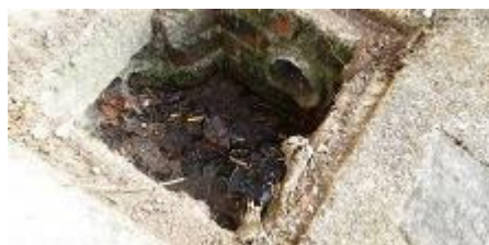
Matériaux : ZPSO-066 Prélèvement : P066 Description : Réseau EU - Conduit en ciment + béton Localisation : EME - Fontainebleau - Zone 2 Résultat : Absence d'amiante
