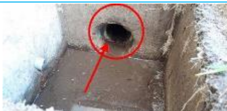
Matériaux : ZPSO-045 Prélèvement : P045 Description : Réseau EU - Conduit en fibres-ciment Localisation : EME - Fontainebleau - Zone 1 Résultat : Présence d'amiante
