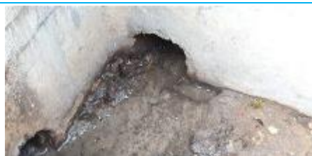
Matériaux : ZPSO-070 Prélèvement : P070 Description : Réseau EU - Conduit en ciment + béton (conduit gauche) Localisation : EME - Fontainebleau - Zone 2 Résultat : Absence d'amiante
