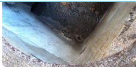
Matériaux : ZPSO-044 Prélèvement : P044 Description : Réseau EU - Conduit en ciment + béton Localisation : EME - Fontainebleau - Zone 1 Résultat : Absence d'amiante
