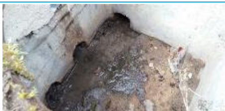
Matériaux : ZPSO-069 Prélèvement : P069 Description : Réseau EU - Conduit en ciment + béton (milieu bas) Localisation : EME - Fontainebleau - Zone 2 Résultat : Absence d'amiante
