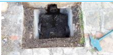
Matériaux : ZPSO-037 Prélèvement : P037 Description : Réseau EU - Conduit en céramique Localisation : EME - Fontainebleau - Zone 1 Résultat : Absence d'amiante
