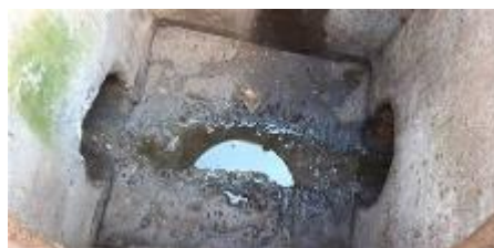
Matériaux : ZPSO-100 Prélèvement : P100 Description : Réseau EU - Conduit en ciment + béton Localisation : EME - Fontainebleau - Zone 2 Résultat : Absence d'amiante
