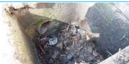
Matériaux : ZPSO-089 Prélèvement : P089 Description : Réseau EU - Conduit en ciment + béton Localisation : EME - Fontainebleau - Zone 2 Résultat : Absence d'amiante
