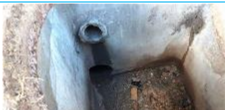
Matériaux : ZPSO-043 Prélèvement : P043 Description : Réseau EU - Conduit en ciment + béton Localisation : EME - Fontainebleau - Zone 1 Résultat : Absence d'amiante
