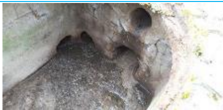
Matériaux : ZPSO-071 Prélèvement : P071 Description : Réseau EU - Conduit en ciment + béton (milieu haut) Localisation : EME - Fontainebleau - Zone 2 Résultat : Absence d'amiante
