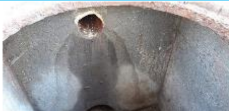
Matériaux : ZPSO-101 Prélèvement : P101 Description : Réseau EU - Conduit en céramique Localisation : EME - Fontainebleau - Zone 2 Résultat : Absence d'amiante
