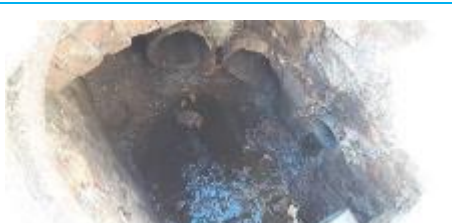
Matériaux : ZPSO-039 Prélèvement : P039 Description : Réseau EU - Conduit en céramique Localisation : EME - Fontainebleau - Zone 1 Résultat : Absence d'amiante
