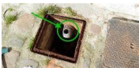
Matériaux : ZPSO-153 Description : Réseau EU - Conduit d'évacuation en PVC Localisation : EME - Fontainebleau - Zone 1 Résultat : Matériau qui par nature ne contient pas d'amiante
