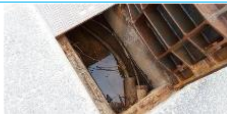
Matériaux : ZPSO-084 Prélèvement : P084 Description : Réseau HT - Parois verticales intérieures - Enduit ciment + béton Localisation : EME - Fontainebleau - Zone 2 Résultat : Absence d'amiante
