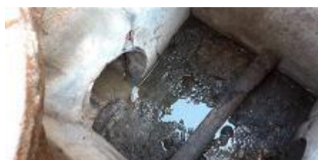
Matériaux : ZPSO-104 Prélèvement : P104 Description : Réseau EU - Conduit ciment + béton Localisation : EME - Fontainebleau - Zone 2 Résultat : Absence d'amiante
