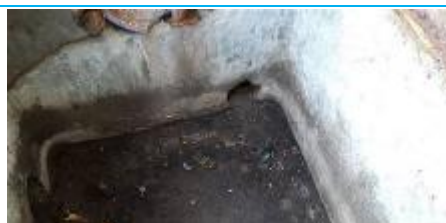
Matériaux : ZPSO-068 Prélèvement : P068 Description : Réseau EU - Parois verticales intérieures - Enduit ciment Localisation : EME - Fontainebleau - Zone 2 Résultat : Absence d'amiante
