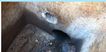
Matériaux : ZPSO-027 Prélèvement : P027 Description : Réseau EU - Parois verticales intérieures - Enduit ciment + béton Localisation : EME - Fontainebleau - Zone 1 Résultat : Absence d'amiante
