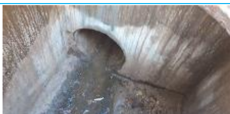
Matériaux : ZPSO-105 Prélèvement : P105 Description : Réseau EU - Conduit en ciment + béton Localisation : EME - Fontainebleau - Zone 2 Résultat : Absence d'amiante
