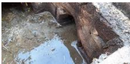
Matériaux : ZPSO-083 Prélèvement : P083 Description : Réseau EU - Conduit en ciment Localisation : EME - Fontainebleau - Zone 2 Résultat : Absence d'amiante
