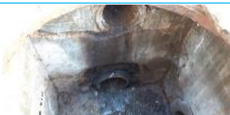
Matériaux : ZPSO-099 Prélèvement : P099 Description : Réseau EU - Conduit en ciment + béton (conduit partie haute du regard) Localisation : EME - Fontainebleau - Zone 2 Résultat : Absence d'amiante
