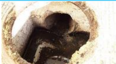
Matériaux : ZPSO-031 Prélèvement : P031 Description : Réseau EU - Conduit en ciment + béton Localisation : EME - Fontainebleau - Zone 1 Résultat : Absence d'amiante
