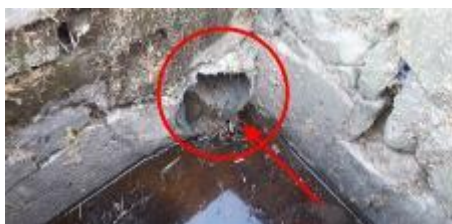
Matériaux : ZPSO-085 Prélèvement : P085 Description : Conduit en fibres-ciment Localisation : EME - Fontainebleau - Zone 2 Résultat : Présence d'amiante
