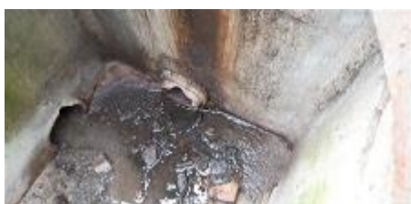
Matériaux : ZPSO-067 Prélèvement : P067 Description : Réseau EU - Conduit en ciment Localisation : EME - Fontainebleau - Zone 2 Résultat : Absence d'amiante
