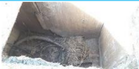
Matériaux : ZPSO-087 Prélèvement : P087 Description : Réseau HT - Parois verticales intérieures - Enduit ciment + béton Localisation : EME - Fontainebleau - Zone 2 Résultat : Absence d'amiante
