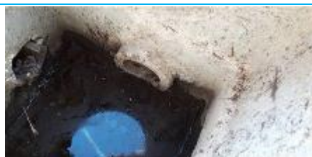
Matériaux : ZPSO-090 Prélèvement : P090 Description : Réseau EU - Conduit en ciment + béton Localisation : EME - Fontainebleau - Zone 2 Résultat : Absence d'amiante
