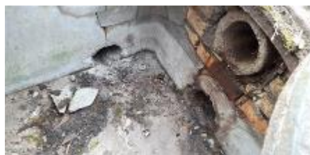
Matériaux : ZPSO-072 Prélèvement : P072 Description : Réseau EU - Conduit en ciment + béton Localisation : EME - Fontainebleau - Zone 2 Résultat : Absence d'amiante
