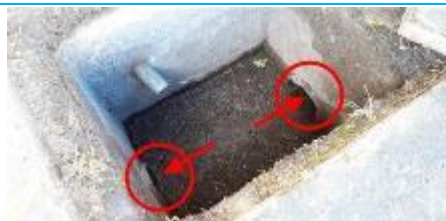
Matériaux : ZPSO-046 Prélèvement : P046 Description : Réseau EU - Conduit en fibres-ciment Localisation : EME - Fontainebleau - Zone 1 Résultat : Présence d'amiante
