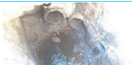
Matériaux : ZPSO-038 Prélèvement : P038 Description : Réseau EU - Conduit en ciment + béton Localisation : EME - Fontainebleau - Zone 1 Résultat : Absence d'amiante
