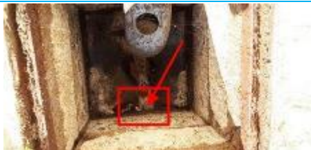
Matériaux : ZPSO-035 Prélèvement : P035 Description : Réseau EU - Conduit en fibres-ciment Localisation : EME - Fontainebleau - Zone 1 Résultat : Présence d'amiante
