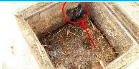
Matériaux : ZPSO-032 Prélèvement : P032 Description : Réseau EU - Conduit en fibres-ciment Localisation : EME - Fontainebleau - Zone 1 Résultat : Présence d'amiante
