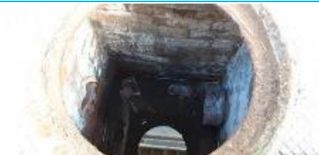
Matériaux : ZPSO-036 Prélèvement : P036 Description : Réseau EU - Conduit en céramique Localisation : EME - Fontainebleau - Zone 1 Résultat : Absence d'amiante
