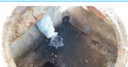
Matériaux : ZPSO-028 Prélèvement : P028 Description : Réseau EU - Conduit en ciment Localisation : EME - Fontainebleau - Zone 1 Résultat : Absence d'amiante
