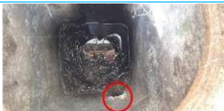
Matériaux : ZPSO-025 Prélèvement : P025 Description : Réseau AE - Conduit en ciment Localisation : EME - Fontainebleau - Zone 1 Résultat : Présence d'amiante
