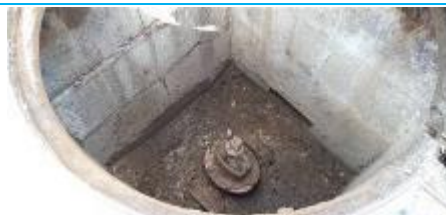
Matériaux : ZPSO-042 Prélèvement : P042 Description : Réseau AE - Parois verticales intérieures murs parpaing - Joint d'assemblage ciment Localisation : EME - Fontainebleau - Zone 1 Résultat : Absence d'amiante
