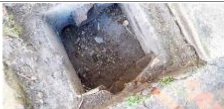
Matériaux : ZPSO-047 Prélèvement : P047 Description : Réseau EU - Conduit en céramique Localisation : EME - Fontainebleau - Zone 1 Résultat : Absence d'amiante
